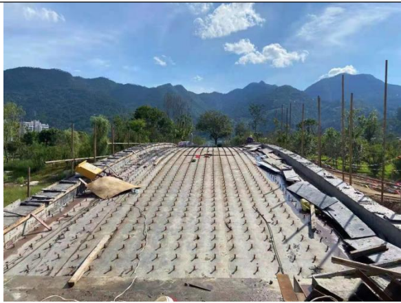
典型现场探伤工作场所-桥梁
